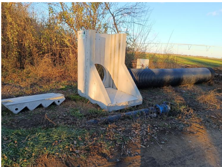
Vízkiemelő építmény elemei
