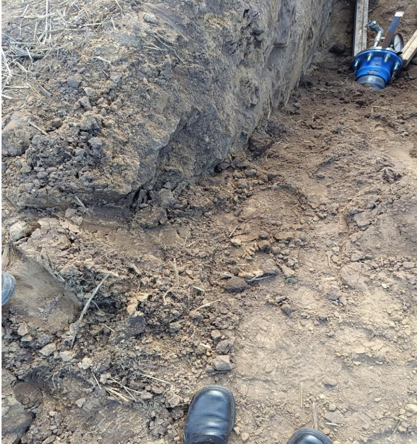
CP4 öntözőcső fektetése
