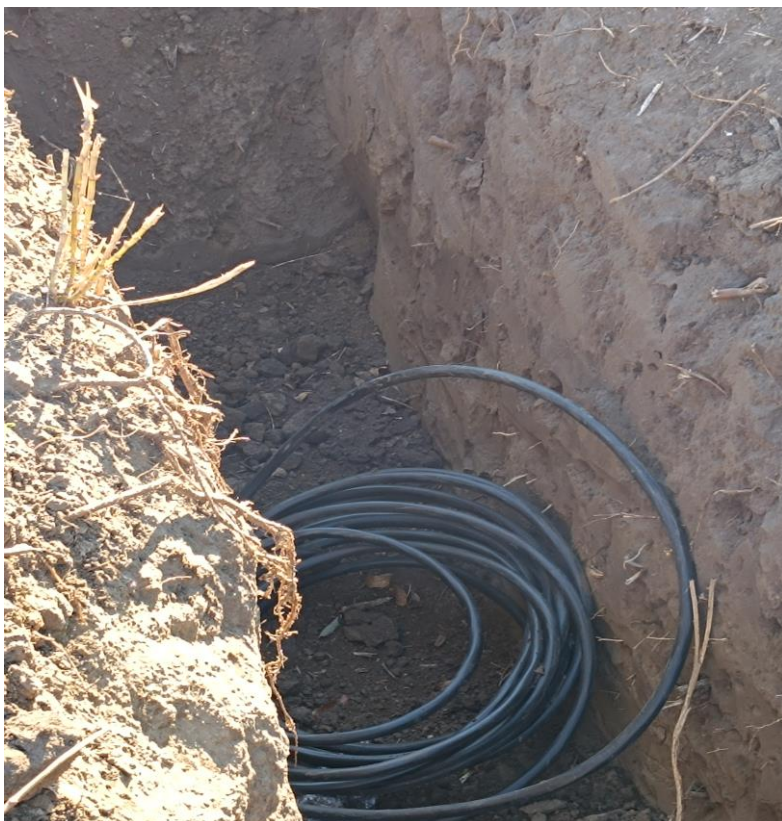
CP3 földkábel fektetése
