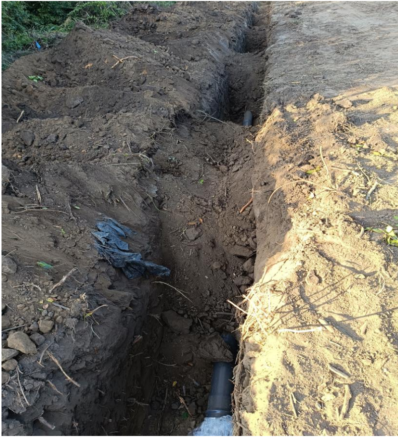
CP3 öntözőcső fektetése
