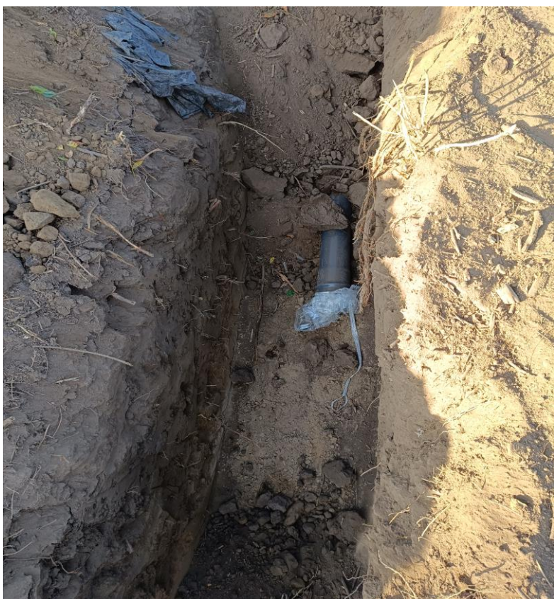
CP3 öntözőcső fektetése
